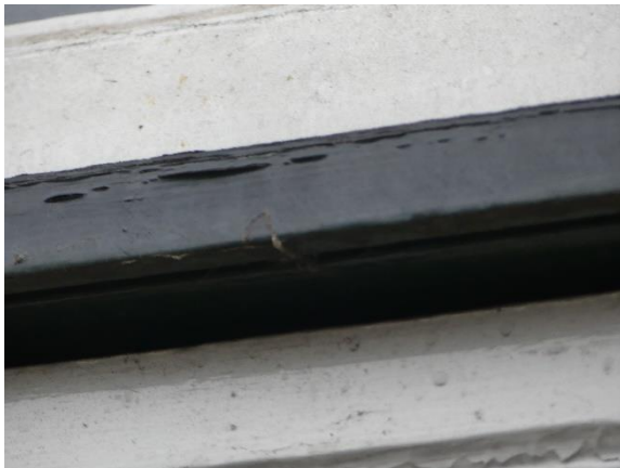
Diverse schade aan het verfsysteem
