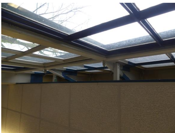
Doorlopende gevelkozijnen voorbij verlaagde systeemplafonds
