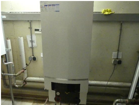
CV ketels met warmwatervoorziening
