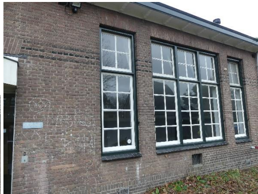
Onderzijde goot met klossen
