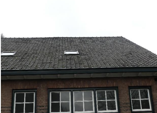
Aanzicht dak en goot
