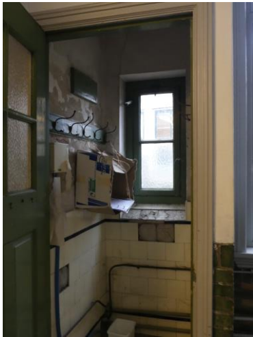
Oude toilet ( niet in gebruik)
