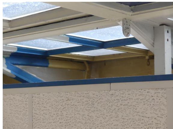
Doorlopende gevelkozijnen voorbij verlaagde systeemplafonds
